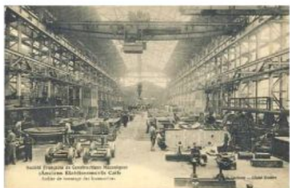
Fig. 82 - Atelier de montage des locomotives.
