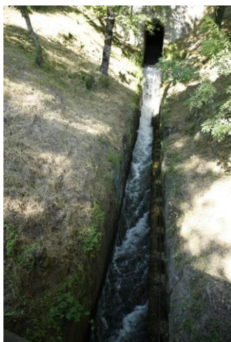
Sortie de la rigole de décharge, en contrebas de la digue, depuis la vanne de la Badorque.
