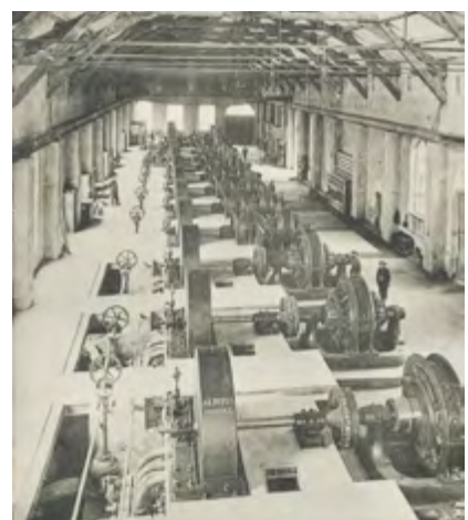
Usine de Calypso, (H) Les chutes de 623 et 134 mètres - (B) Partie de la salle des machines turbines A. H. Bouvier et de dynamos Thomson-Houston Source : IHA - 1911 - Brochure de présentation de la Compagnie des produits chimiques d'Alais et de la Camargue
