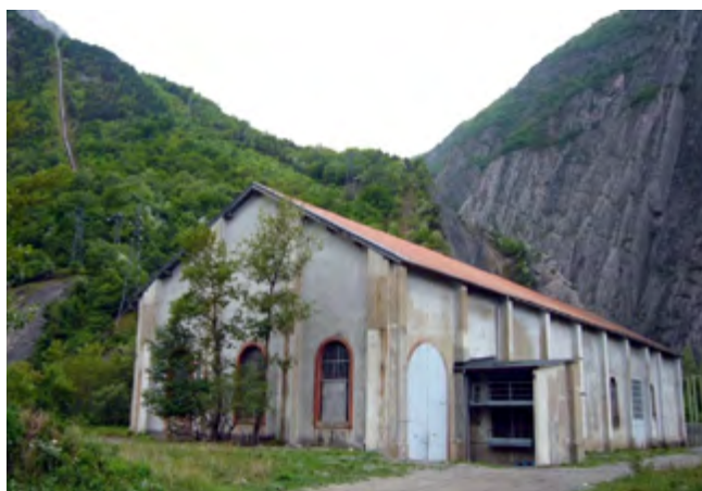
D - La centrale hydroélectrique de Calypso en 2007. En arrière-plan, la conduite forcée
