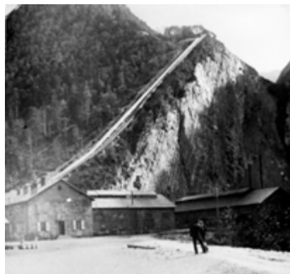
(H) 1907 - Usine Calypso, vue générale. Le pont en acier sur l'Arc, les trois salles d'électrolyse et les nouvelles conduites forcées de la grande chute (en clair) - Source : La Houille Blanche 1946
