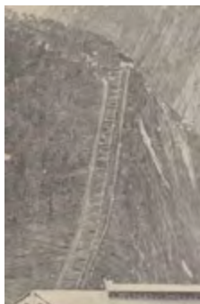
(H) Vue générale de l'usine de Calypso en 1905 et de la fin de la première tranche des travaux. (D) Détail - Pose de la première conduite forcée de la grande chute de 623 mètres. Sur la droite, les deux conduites de la petite chute de 134 mètres et sa chambre d'eau en hauteur.
