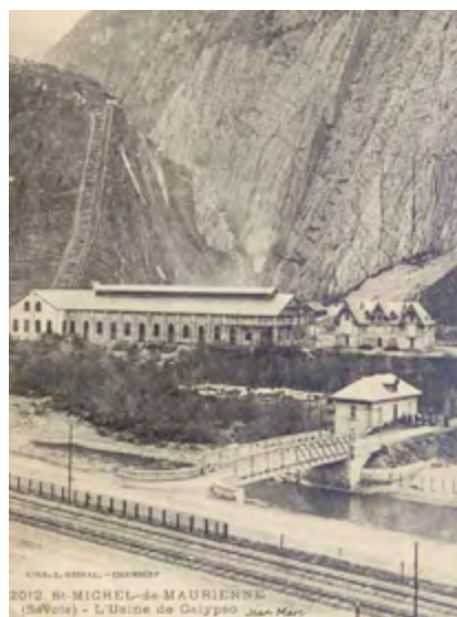
(H) Vue générale de l'usine de Calypso en 1905 et de la fin de la première tranche des travaux. (D) Détail - Pose de la première conduite forcée de la grande chute de 623 mètres. Sur la droite, les deux conduites de la petite chute de 134 mètres et sa chambre d'eau en hauteur.
