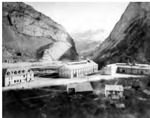
Usine Calypso en 1897, de gauche à droite : La maison du directeur, la salle d'électrolyse, la fonderie, la salle des machines, la conduite forcée. Au premier plan les locaux annexes.
