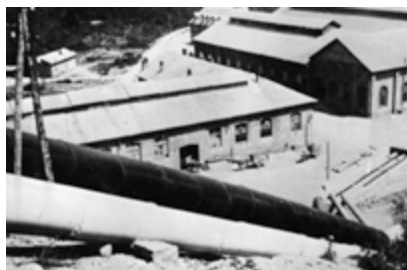
Usine Calypso. Sur la droite de la photographie, l'arrivée des conduites forcées à la salle des machines.
