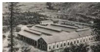
Usine de Calypso. Vue sur les trois salles d'électrolyse. Au premier plan, la salle des machines et son extension sur la droite.
