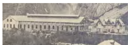
1905 - Détail - Travaux de construction de la deuxième salle d'électrolyse
