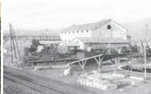
1916 - Construction de l'usine. Hiver 1915. Archives de l'usine
