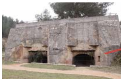
Fours à chaux
