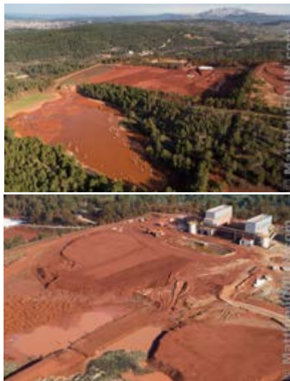
Vues en 2016 du site de Mange-Garri à Bouc-Bel-Air près de Gardanne où sont stockés les résidus de bauxite sur 7 bassins puis traités par deux filtres-presses Source : © Matthieu Colin
