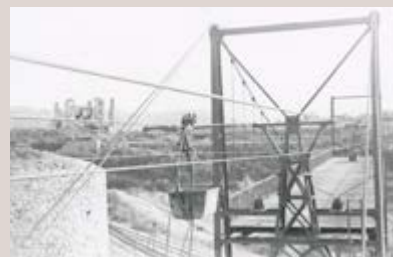
(G) Le télébenche de la SEMF en gare de Tourves. Sur la gauche le château de Valbelle (D) Un tronçon de la ligne aérienne. On peut remarquer les pylônes métalliques installés vers 1930
