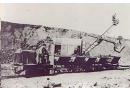
Motrice diesel – Remplissage des chariots à l'aide d'une pelle mécanique sur la carreau de Tourves
