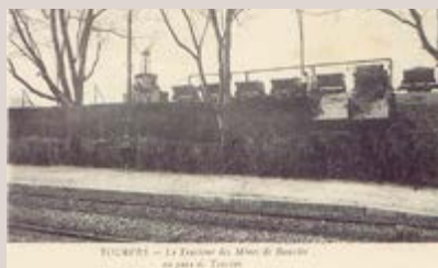
Locotracteur électrique - Déchargement en gare de Tourves au niveau du quai surélevé longeant les voies
