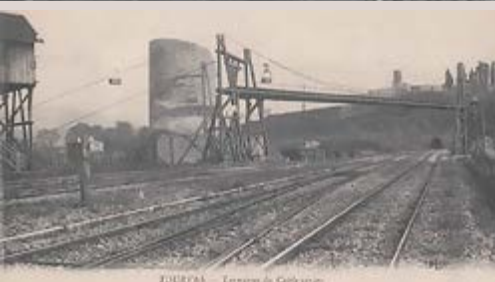
Gare de Tourves - Le pont du transporteur de bauxite par nacelles des mines de la SMEF jusqu'à la gare de Tourves en 1915.
