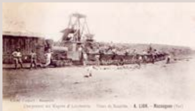
Exploitation de M. Adolphe LION - Chargement mécanisé des bennes tractées par une locomotive à vapeur vers 1903
