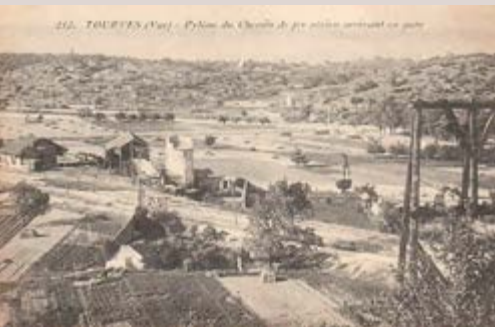
1912 - Arrivée des bennes remplies de bauxite à la gare de Tourves. Structure des pylônes en bois
