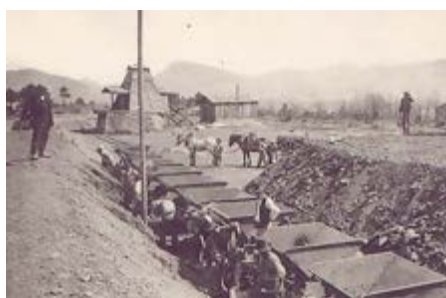
Chargement manuel des wagonnets à Tourves vers 1910
