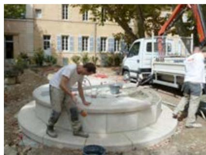
(Gauche) Le 11 septembre 2014, pose du parement de sol. (Centre) le 15 septembre, pose du parement de façade et coulée en béton de la dalle de la fontaine. (Droite) Le 16 septembre, pose du parement d'assise.
