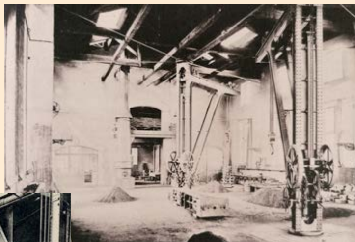
1890 - Atelier de fonderie - Les deux cubilots, les grues... Au milieu, entre les deux cubilots, le passage vers la zone de stockage et le parc à châssis, au fond à droite les portes de l'étuve
