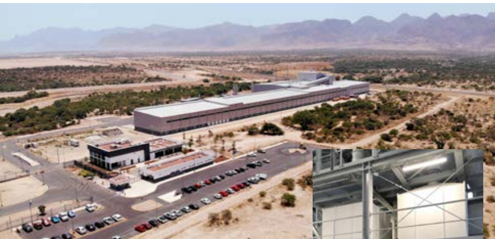
Réalisation d'une fonderie.
