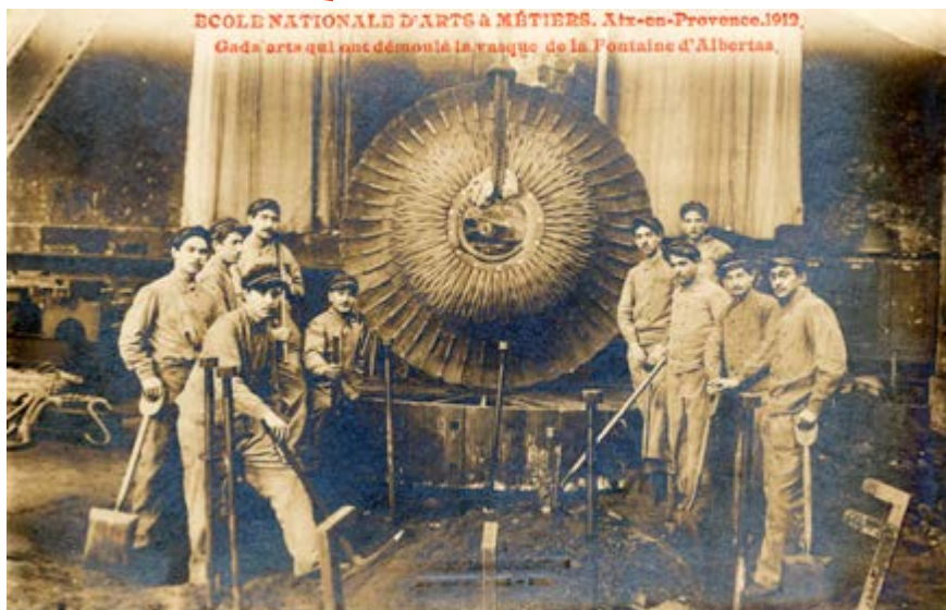
Le moule est décoché par les élèves. La vasque brute de coulée Source : Photographie Henry ELY, Aix-en-Provence
