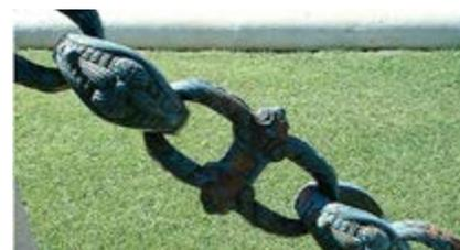
Les chaînes en fonte de la Fontaine de la Rotonde et son principe de moulage en mottes - Source : ENSAM Aix-en-Provence - Yves Liccia
