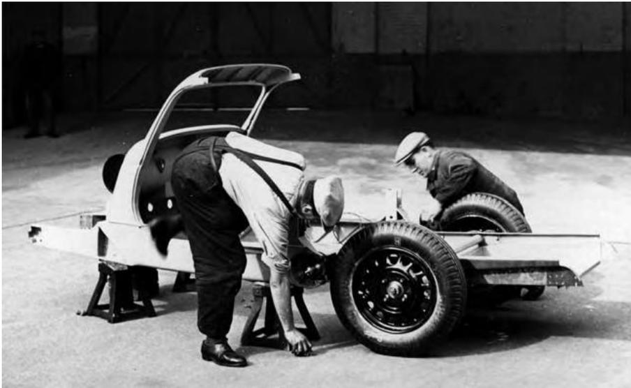
*Assemblage par boulonnage des six parties de la carcasse coulée de l'Amilcar Compound, 1937*
