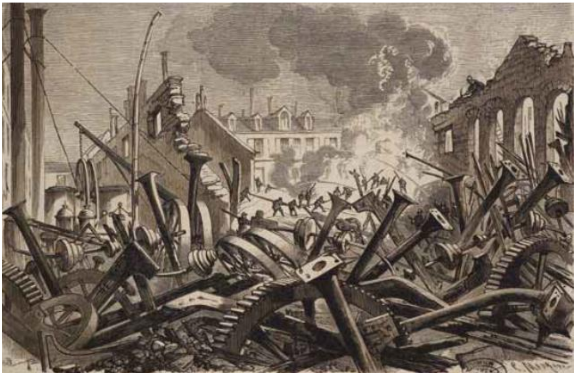
Vue de l'usine Cail & Cie, Aspect de la grande salle des machines après l'incendie de 1885 - gravure, 1865
