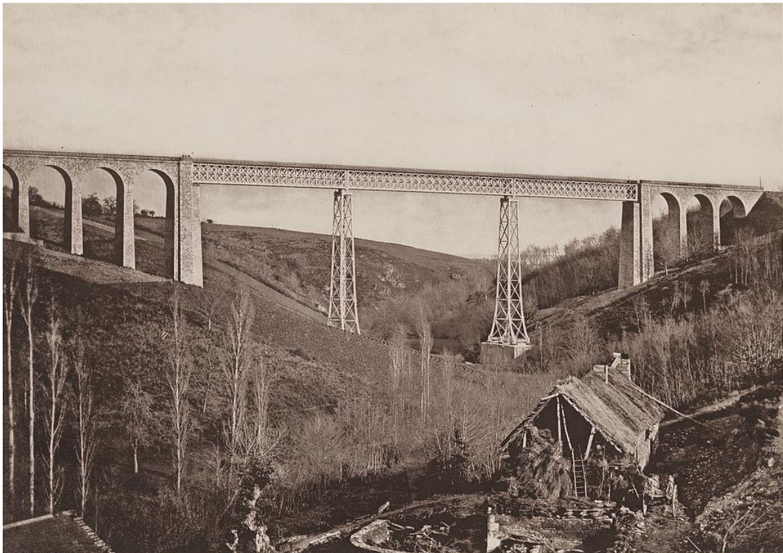
Le Viaduc du Bellon - Louroux, Allier (CAIL & Cie et Cie de FIVES-LILLE).
