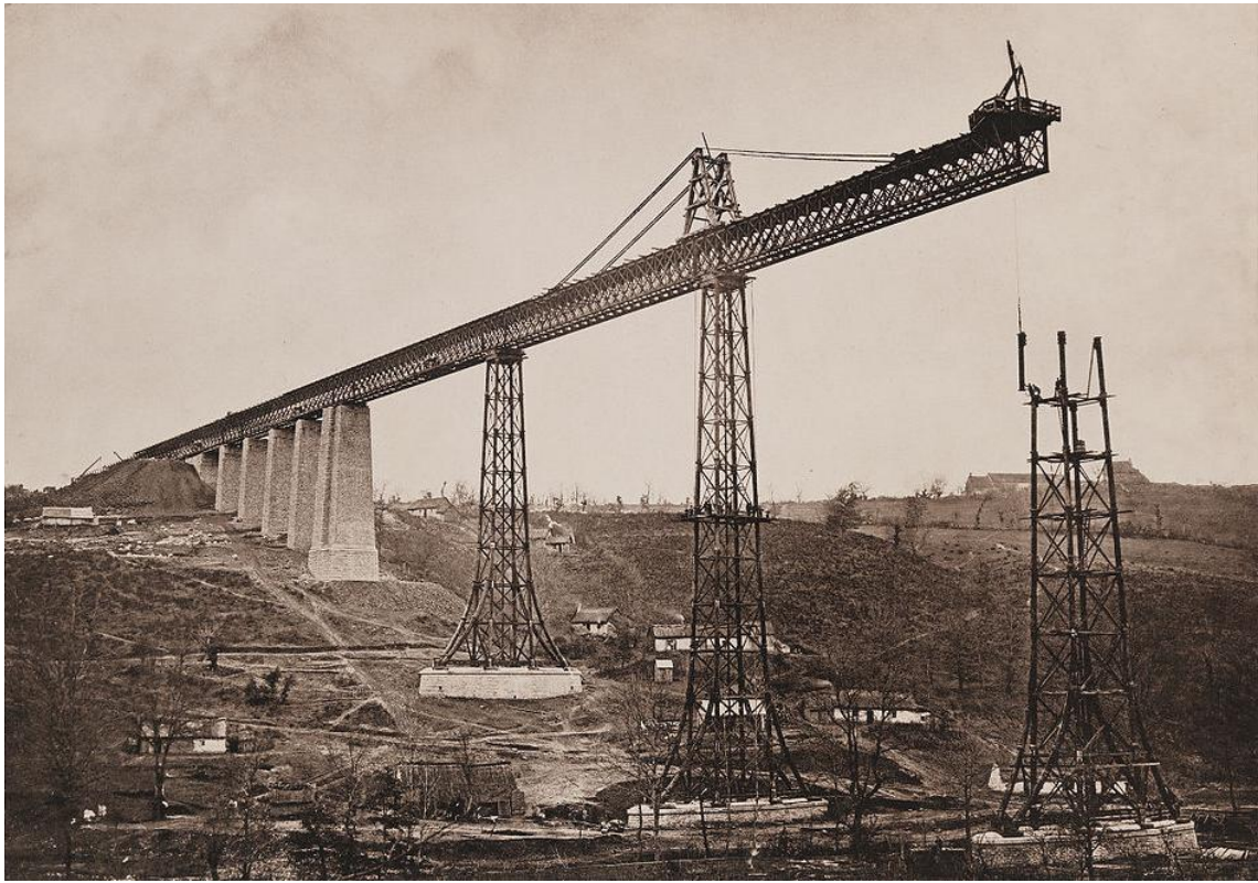
Le Viaduc de la Bouble - Louroux, Allier (CAIL & Cie et Cie de FIVES-LILLE).
