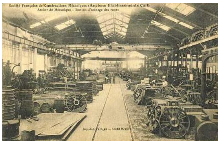
SFCM - Usines de Denain : Atelier de Mécanique - Section d'usinage des roues.
