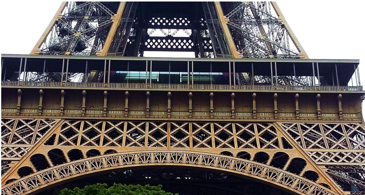
Frise côté Sud-ouest face à Grenelle. Le nom CAILL est le cinquième en partant de la droite.
