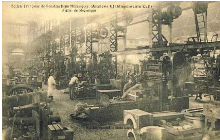
SFCM - Usines de Denain : Atelier de Mécanique.
