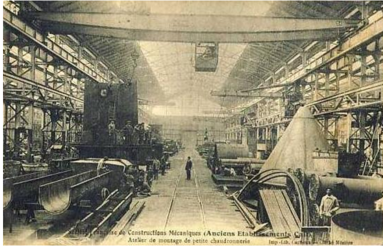
SFCM - Usines de Denain : Atelier de montage de petite chaudronnerie.
