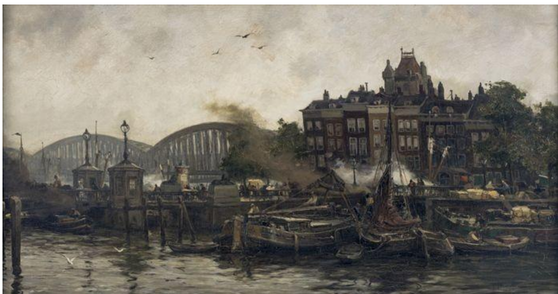
Pont Willemsbrug à Rotterdam par August Willem van Voorden (1905).
