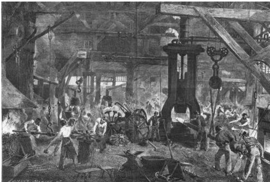
La forge de l'Usine de Grenelle (Dessin d'Edmond Morin-Les grandes usines de France, 1865, p. 8-9)
