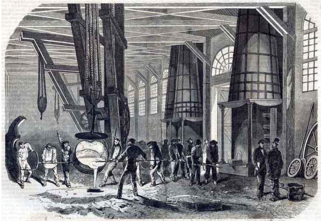
La fonderie de l'Usine de Grenelle (L'illustration - association C.A.I.L.)
